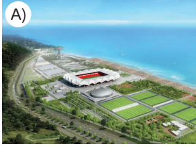
Trabzon Akyazı Stadi
